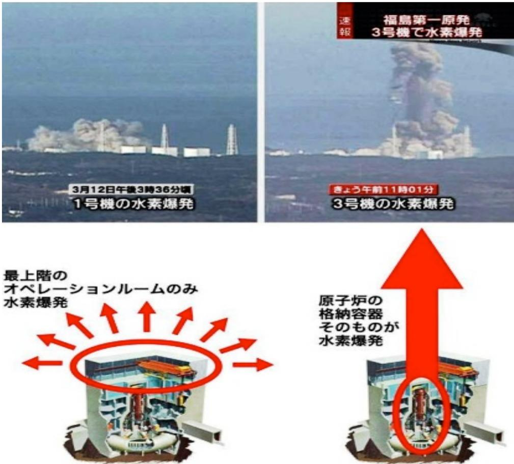
**Figura 24- Esplosioni dell'edificio reattore unità 1 e unità 3** [I termini in giapponese significano: foto a sinistra, "12 marzo, ore 3:36 pm, esplosione idrogeno dell'unità n.1"; foto a destra, "oggi alle 11:01 esplosione idrogeno dell'unità n. 3"; disegno sotto a sinistra, "è esplosa soltanto la sala operativa all'ultimo piano"; disegno di sotto a destra, "è esploso il contenitore del reattore"]
