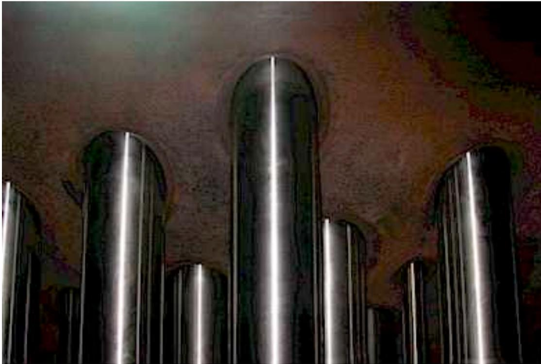
**Figura 13 - Penetrazioni nella parte inferiore del vessel**
